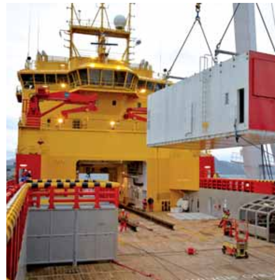
Ein Brennstoffzellen-Hotmodul wird als Stromerzeuger auf der Viking Lady eingebaut
